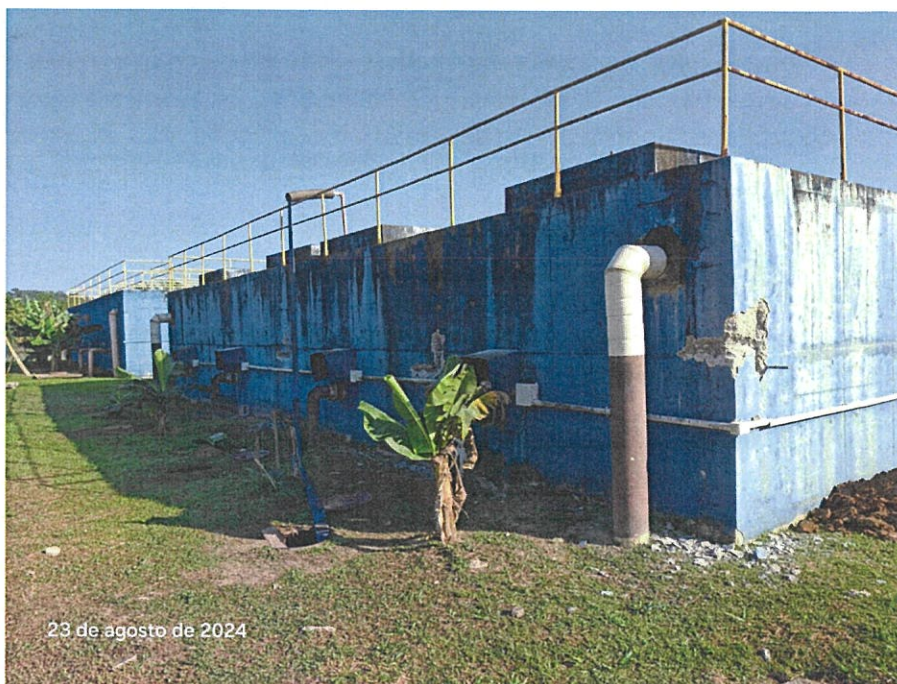
Foto 01 – Inspeção Estrutural – Módulo III
