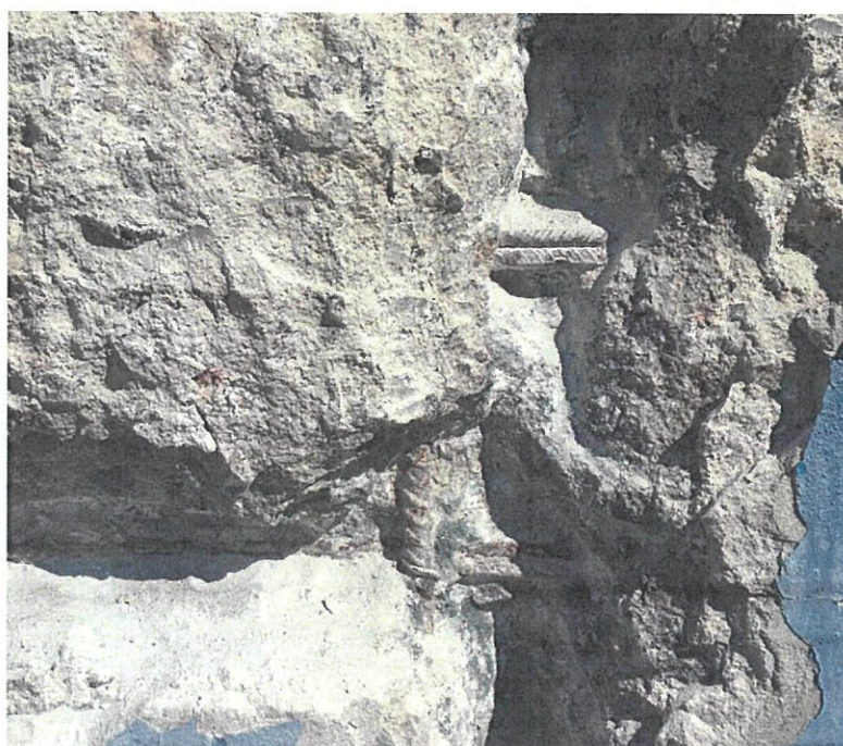
Foto 04 – Inspeção Estrutural – Módulo III
