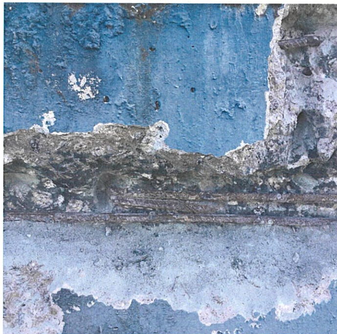
Foto 03 – Inspeção Estrutural – Módulo III
