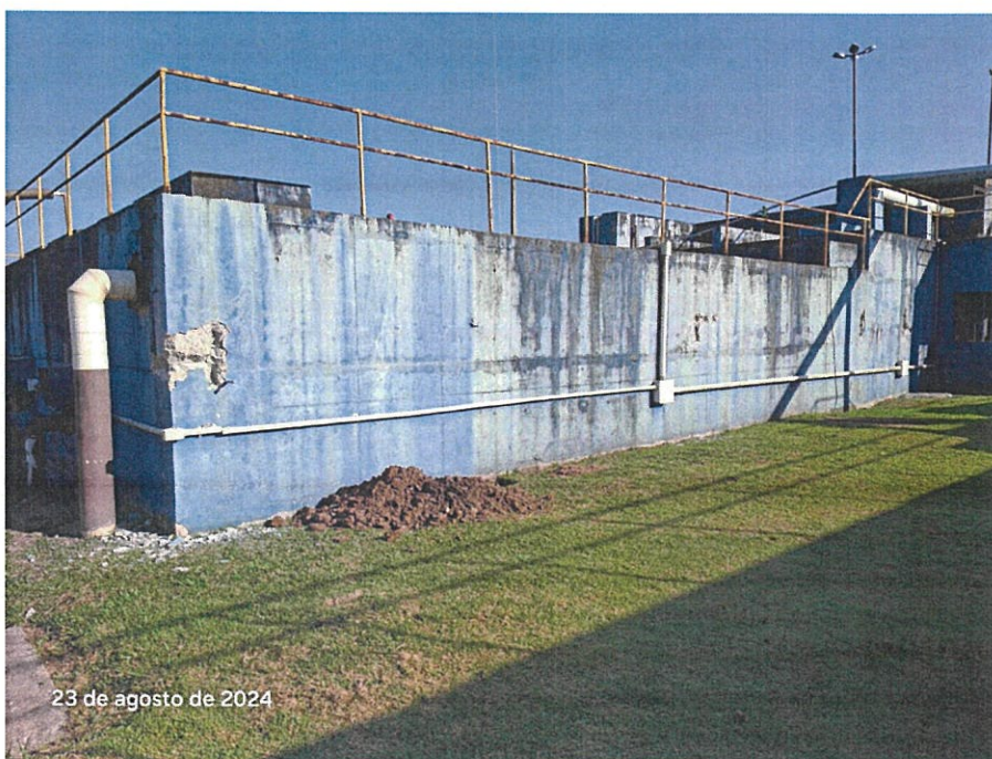
Foto 02 – Inspeção Estrutural – Módulo III
