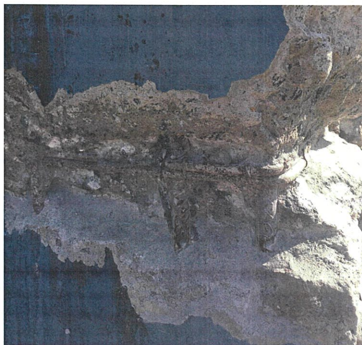
Foto 06 – Inspeção Estrutural – Módulo III
