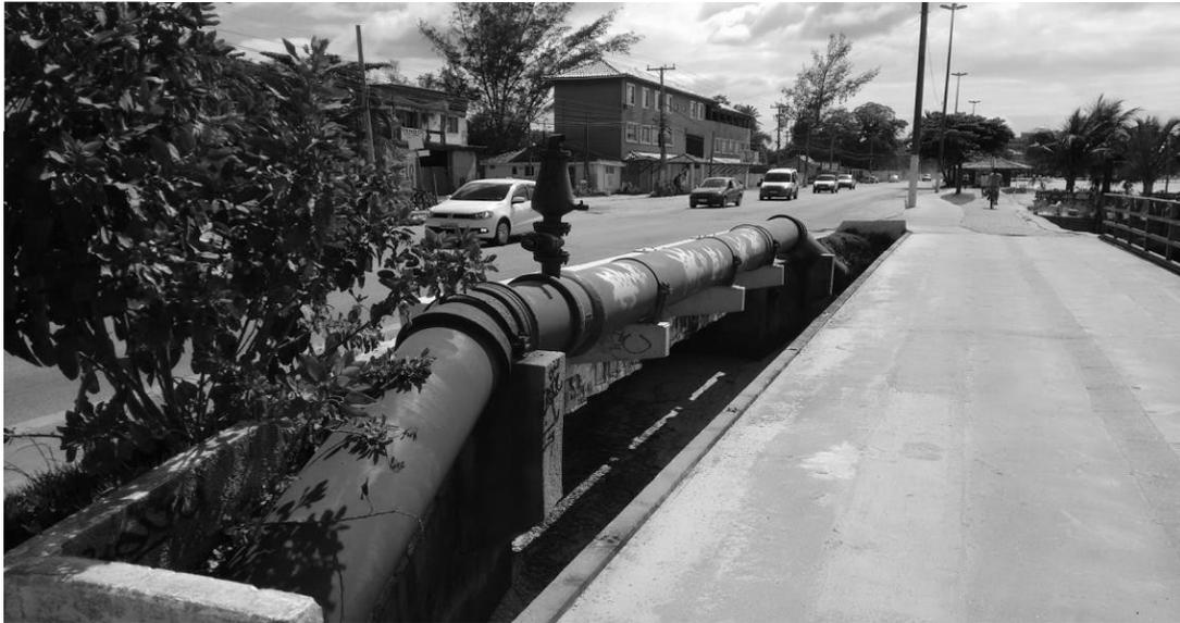
Figura 5 – Travessia Linha de Recalque SS5 – Recalcando do SS5 para SS2.
